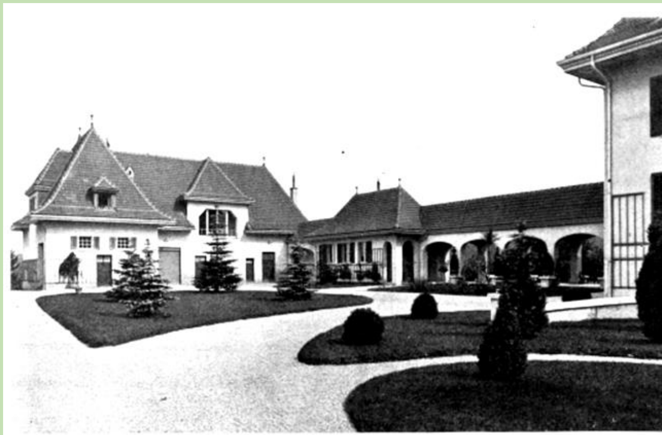
Teilansicht mit Autogarage, Stall und Waschgebäude
